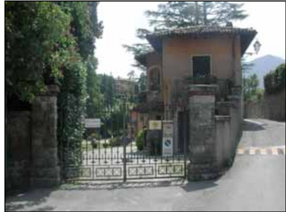
Foto 11 – Vista dell'ingresso all'asilo
