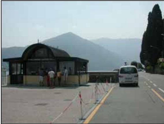
Foto 8 – Vista della Strada Statale 340 (verso Tremezzo)
