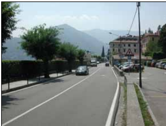
Foto 3 – Vista della Strada Statale 340 (Verso Tremezzo)
