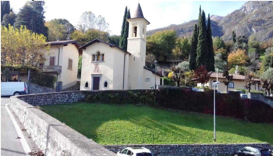
Fig. 15 – Chiesa di San Rocco
