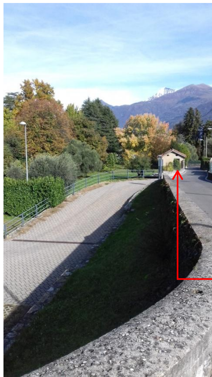
Fig. 16 - Via - Diaz n° 2 – edificio agricolo
